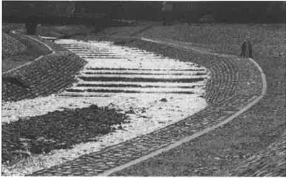
図7 環境に配慮したと考えられるが、生物に対しては的外れな河川工事の一例（富山県）
