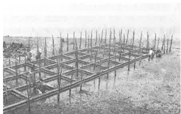
図 1 逆さ竹林魚礁（事業モデル） 筆者と学生たちが田名臨海実験実習場の前の干潟に設置した。
