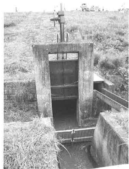
写真4 ため池の水は樋管を通して堤防の反対側の排水口から流れ出すので、その直下に、外来魚の流出を防止するために、網や簾を設置する。この池では、鋼製の枠組みにプラスチック製のネット地(トリカルネット)を貼り付けた頑丈なスクリーンが据え付けられていた。
