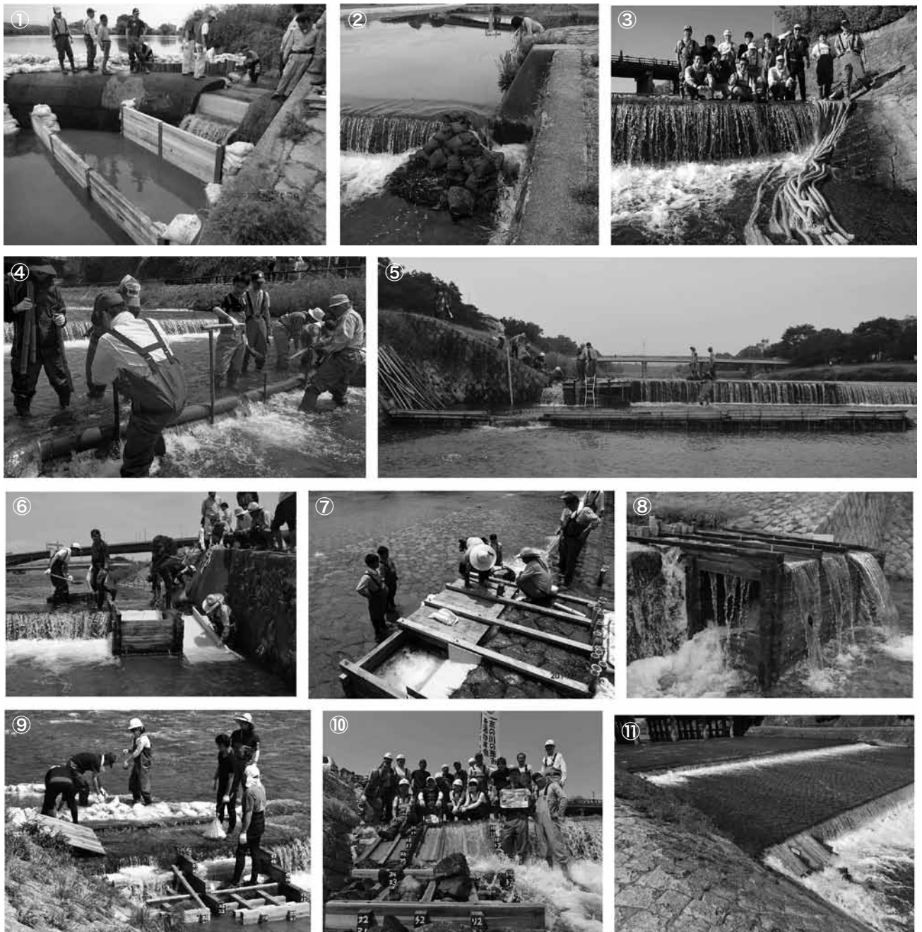
図2 活かす会が鴨川に設置したさまざまなタイプの魚道の例
