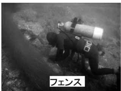
(b) ウニ侵入防止フェンスの設置
