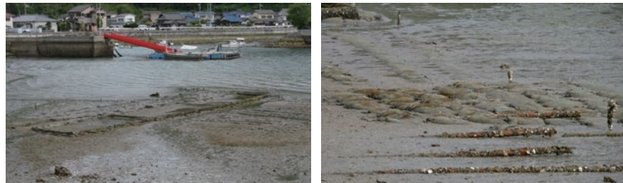
通水管の設置状況
