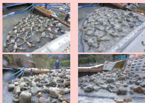
二次コン打設前
