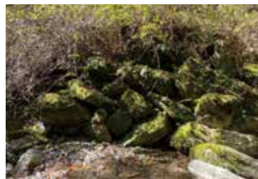
河川の空石積護岸(谷積み様式)
