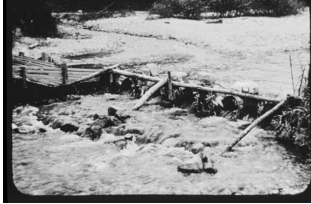
付写4：地獄川（湯川の下流。湖から竜頭の滝下まで。）に設置された梁 ホンマスの産卵期になると本流全体を堰き止め、一部に上り梁を設置して、親魚を捕獲した。
